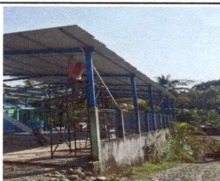
Foto 4: Pintura en muros exteriores e interiores
