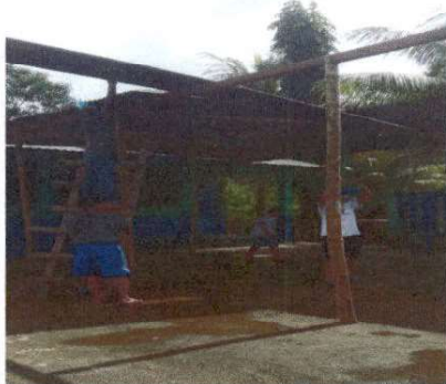
Foto1: Sustitución de lámina por lámina troquelada aluzinc calibre 26 mas sustitución de estructura de soporte de metal por metal.
