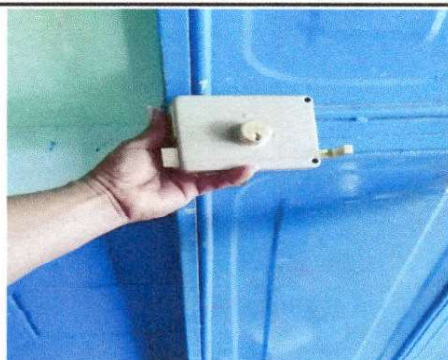
Foto 3: Sustitución de chapa
