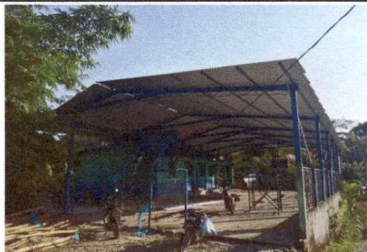
Foto 2: Sustitución de capote para lamina troquelada.
