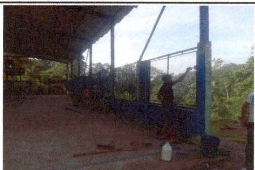
Foto 5: Pintura en muros exteriores e interiores
